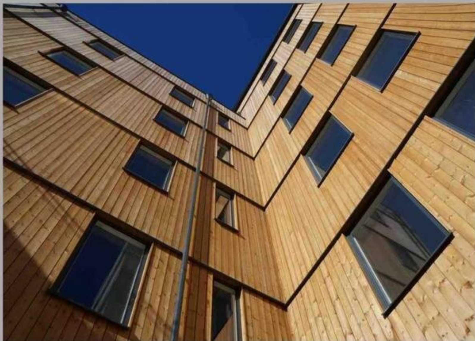
Vallastaden. Ort Linköping Värmebehandlad Furu, Brandimpregnerad Fire X
